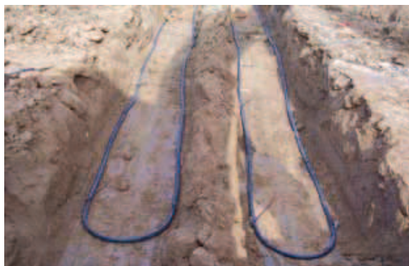
Intercambiador horizontal de lazo simple
