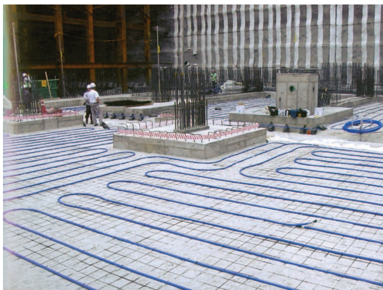
(b) Activación de la solera de la universidad femenina de Ewha de Seúl (Corea del Sur)
